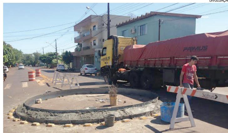
Guias definitivas em concreto armado no perímetro urbano de Marechal Cândido Rondon: mais segurança e fluidez no trânsito
