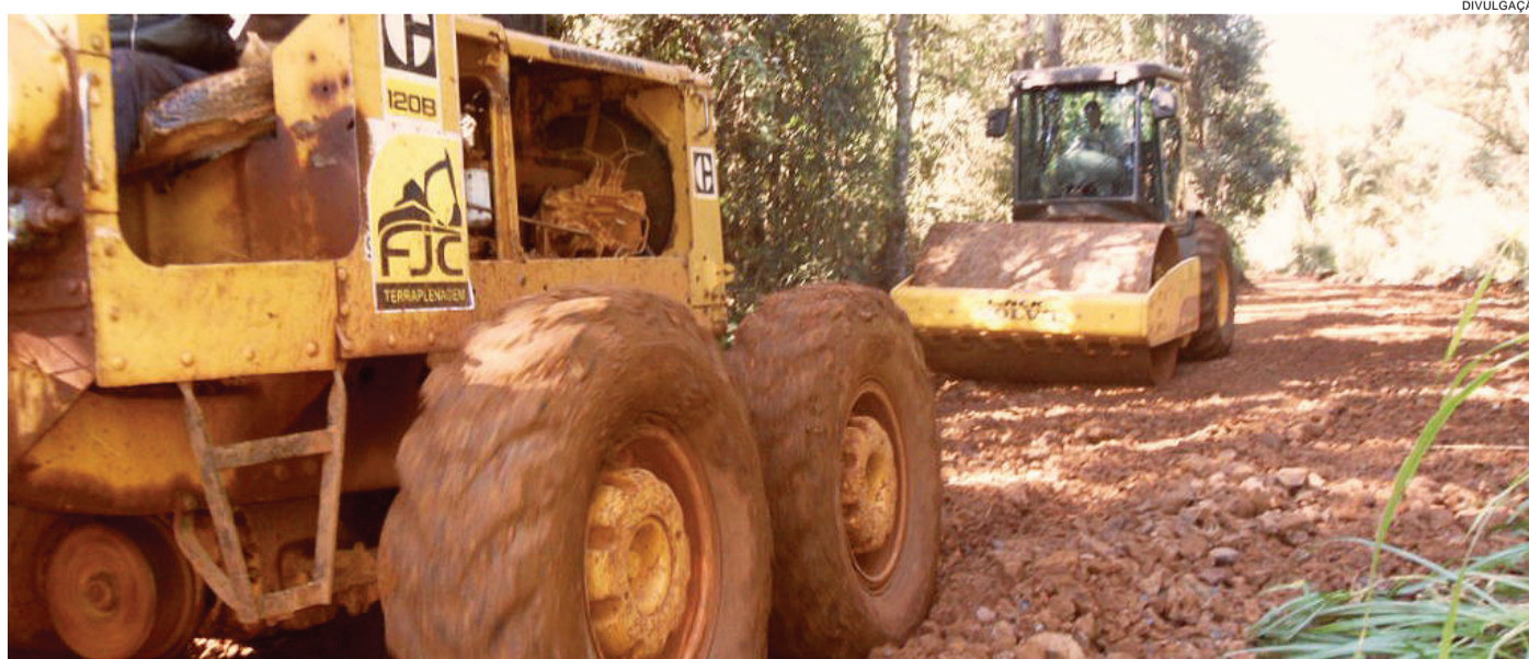
Trabalhos de melhorias de estradas rurais estão sendo realizados em várias localidades do interior
