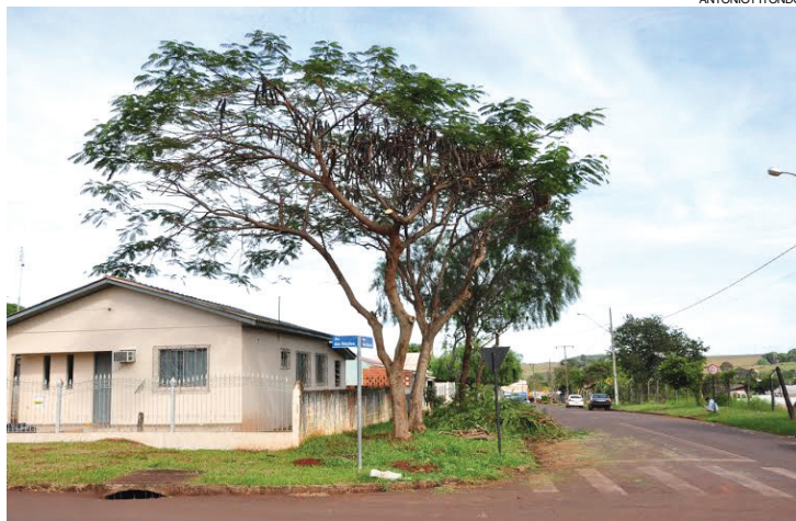
Intenção é reduzir riscos também à rede de distribuição de energia
