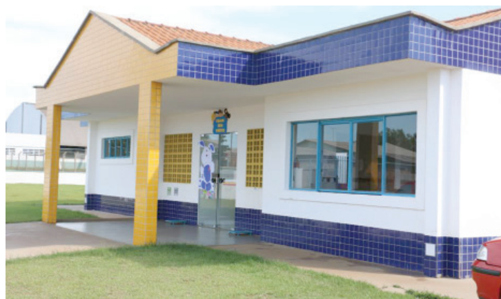
Uma das unidades prontas e já em funcionamento: melhorias
