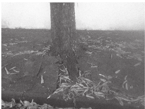
Figura 04: Raízes das árvores em conflito com a calçada. Fonte: Elaborado pelo autor.
