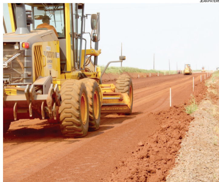
Obras no trecho entre Toledo e Rondon estão adiantadas em alguns pontos
