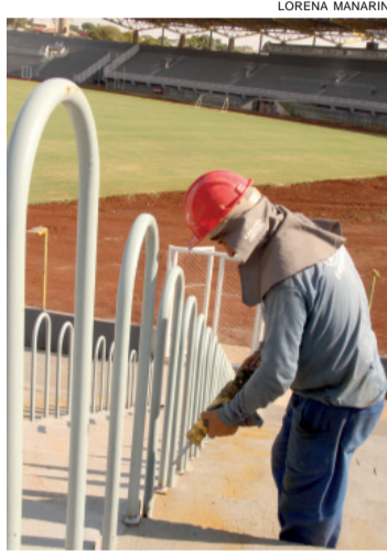
Poucos operários seguem trabalhando nas obras no estádio
