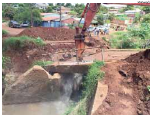
Melhora do tempo permitiu que máquinas fizessem a demolição do que sobrou da ponte
