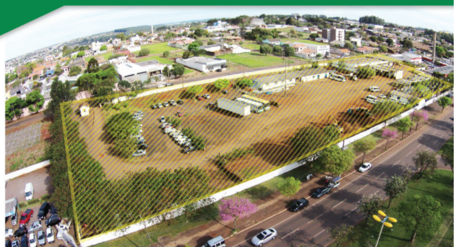
DESTAQUE 2: Terrenos na Avenida Tancredo Neves - Parque de Máquinas
