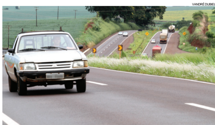
Motoristas precisam redobrar a atenção ao trafegar pela BR-467: mato alto dificulta visibilidade de placas de sinalização
