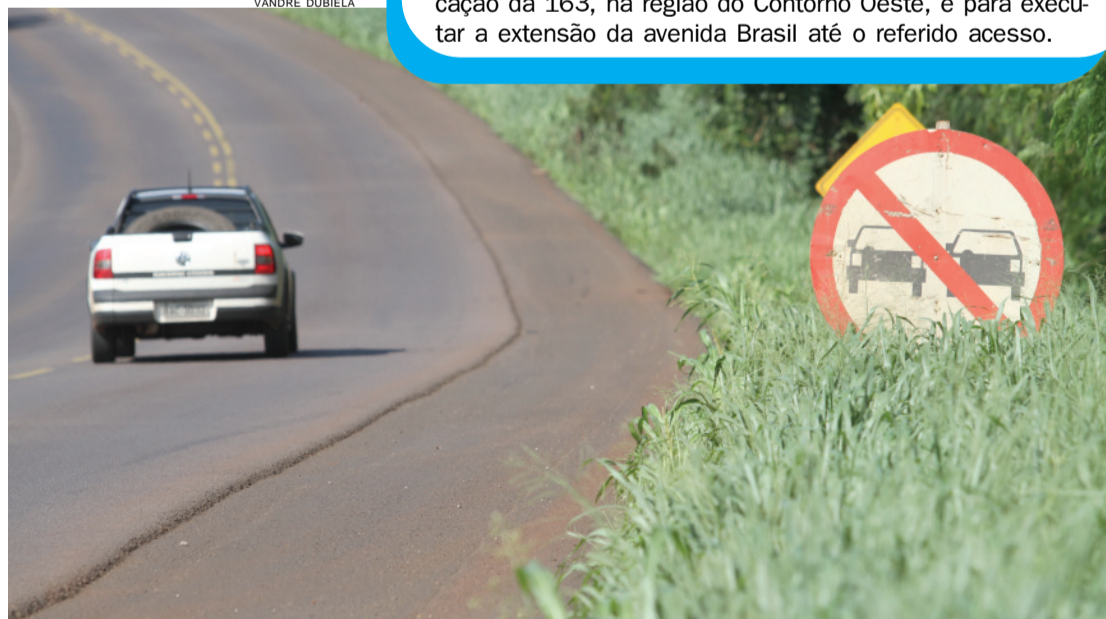
Sem roçadas regulares, mato cresce e já começa a esconder placas importantes
