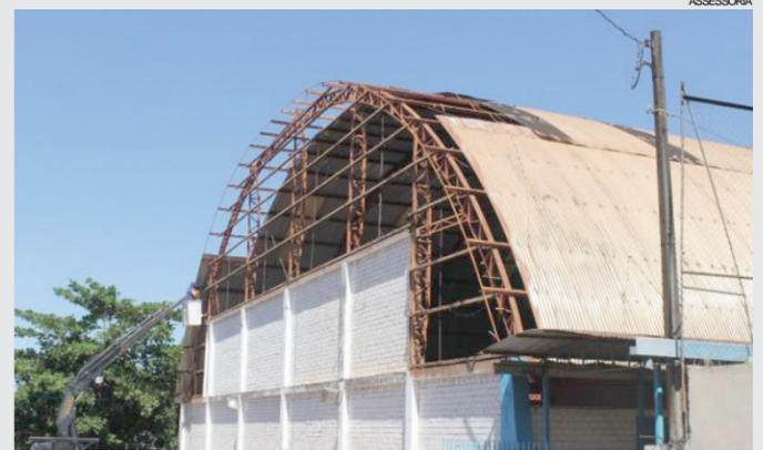
**Palotina** - A administração pública de Palotina iniciou a reforma do Ginásio de Esportes GoolBool. Serão investidos recursos próprios no valor de R\$ 225.930 na retirada e na substituição das telhas da cobertura, limpeza e pintura da estrutura metálica, e reforma nas ins-
