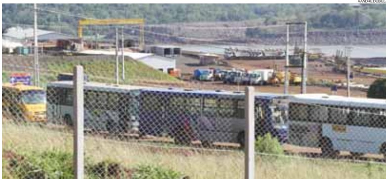
Depois de 17 meses parada, usina volta a movimentar canteiro de obras entre Capanema e Capitão
