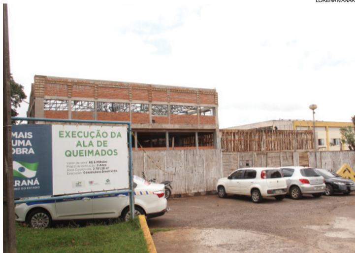
Informações dão conta que 40% das obras da Ala de Queimados já foram concluídas
