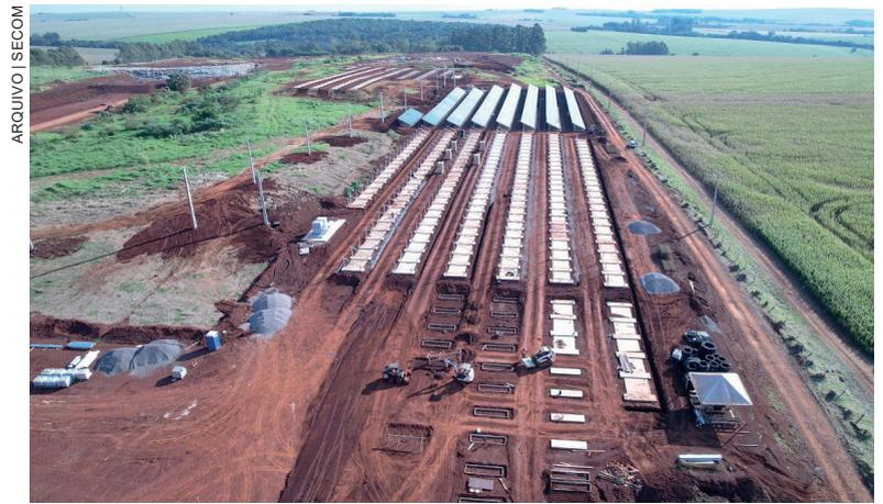
A usina está sendo construída em uma célula desativada no aterro sanitário
