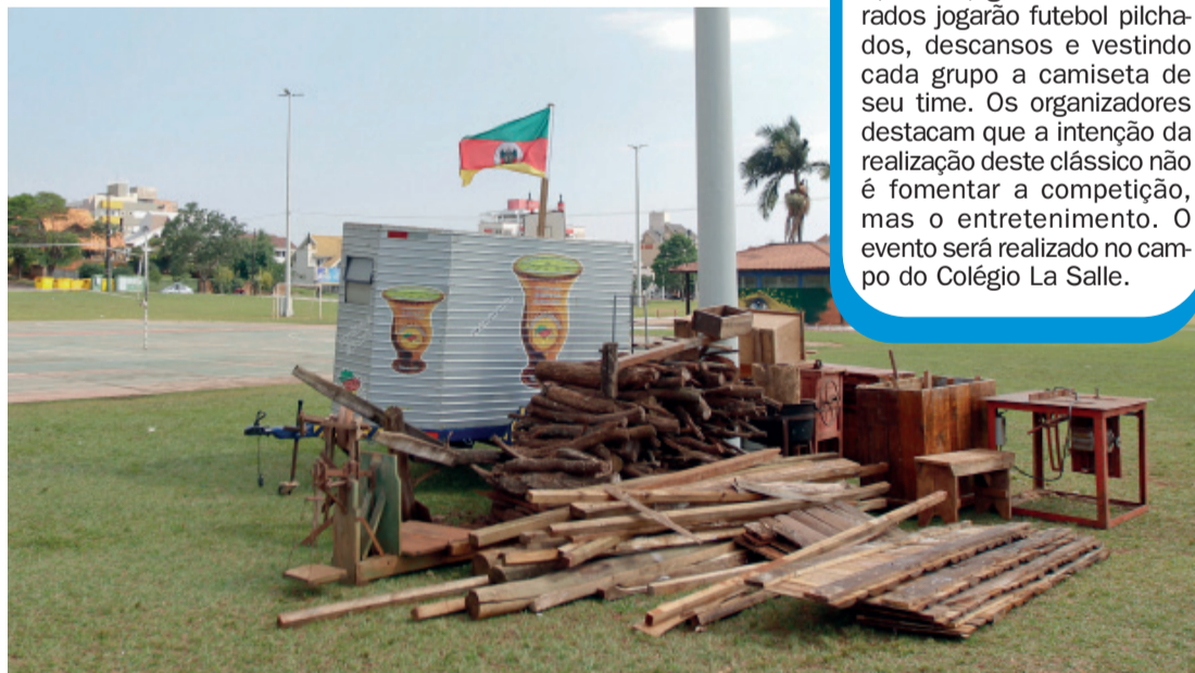
Parque Ecológico Diva Paim Barth já está recebendo a estrutura para montagem do galpão
