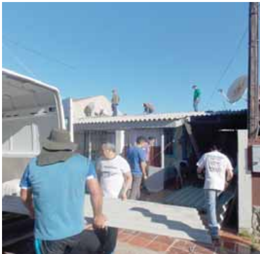
Voluntários TJs arrumam telhado danificado pelo temporal
