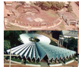
A Catedral de Cascavel em obras e concluída
