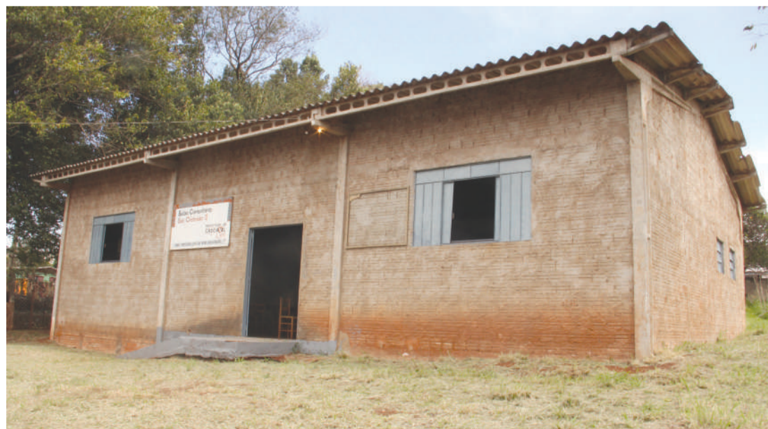
Construído em 1999, salão comunitário é alvo das reivindicações da comunidade
