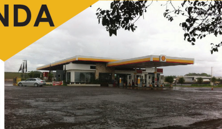
Posto de combustível, com 32 bicos de abastecimento, tançagem para 180 mil litros, loja de conveniência, churrasqueira, restaurante, borracharia e mecânica. Escritório, sistema telemed, padrão novo exigido pelo IAP e rampas. R$ 15.000.000,00. Ref: PT0009
