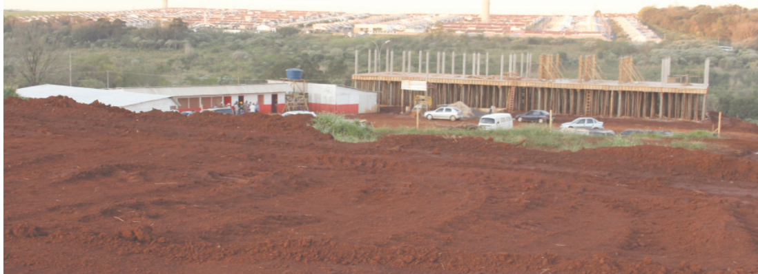
Construção está no segundo pavimento do alojamento do Centro de Atletismo
