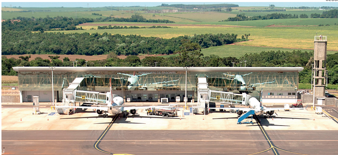
A obra prevê o alargamento das vias marginais, na área industrial nas proximidades do Aeroporto Regional de Cascavel
