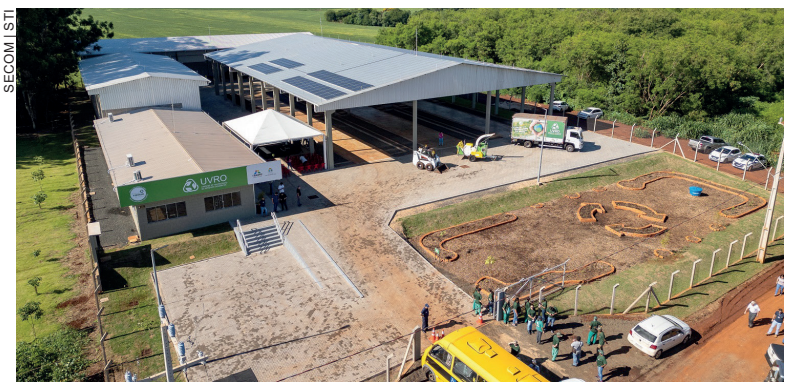
A UVRO vai reduzir a quantidade de resíduos enviados ao aterro sanitário municipal
