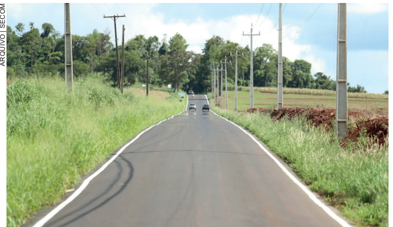
Na Rio da Paz, a obra inicia na Carlos Gomes e vai até a área rural, para terminar um trecho que ficou fora da revitalização feita em 2022
