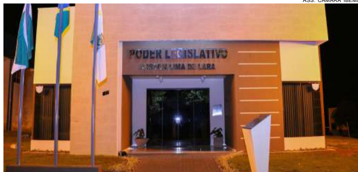
A ampliação e a revitalização da estrutura custaram R$ 140 mil
