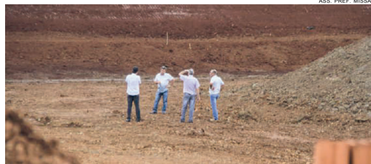
Obras do futuro cartão-postal de Missal estão adiantadas
