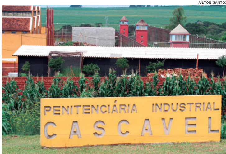
No Oeste são duas suspensões, em Foz e Guaíra; PIC é terceira obra mais avançada, com apenas 10% de conclusão
