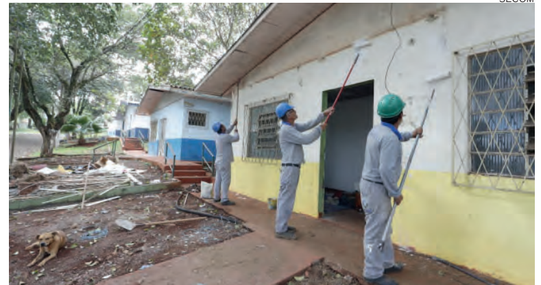
A primeira etapa dos trabalhos já está em andamento
