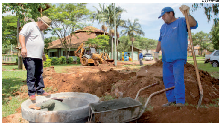
Investimento em obra foi de R$ 20 mil
