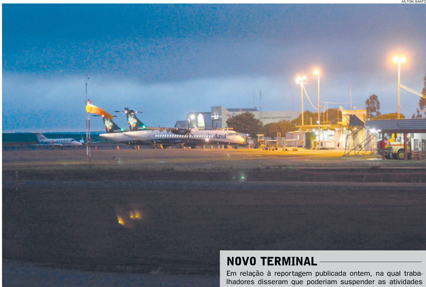
Voo foi cancelado devido a problemas técnicos no sistema de balizamento da pista de pouso e decolagem
