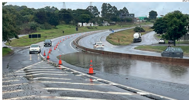
A PRC-467 acabou sendo parcialmente interditada durante toda a manhã para garantir a segurança dos motoristas
