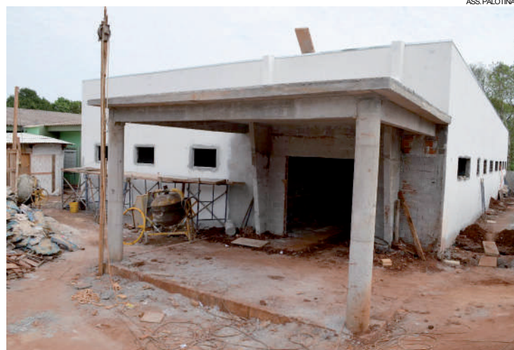
Obras dos leitos de UTI no Hospital Municipal de Palotina
