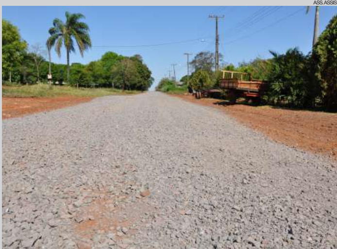
Município adquiriu 10 mil metros de pedra. São mais de R$ 400 mil em investimento para a área rural
