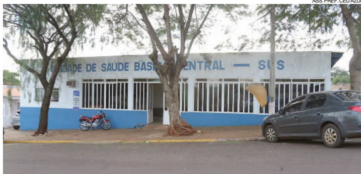
O prédio que será demolido em alguns dias é do Estado e atende a saúde pública em Céu Azul desde 1973: leilão será no dia 16
