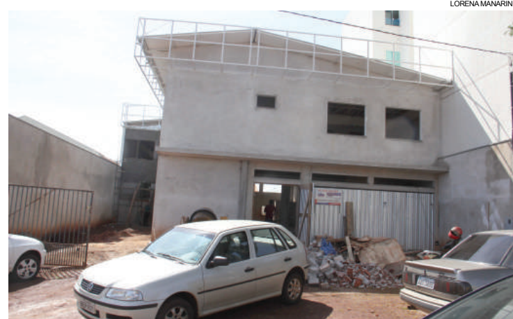
Unidade locada ainda está sendo reformada para a transferência da UBS do Bairro Claudete
