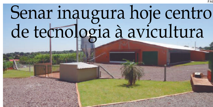
A área construída à nova estrutura é superior a 1,2 mil metros
