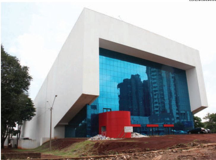
Obra do Teatro Municipal foi retomada há oito anos e ainda não tem data para conclusão
