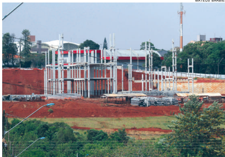
Obra está sendo erguida em área que possuía diversas nascentes
