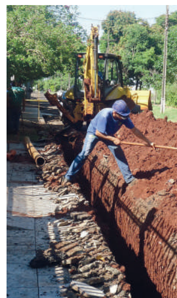
Trabalhadores atuam nas obras
