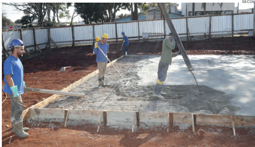
A obra está sendo feita em modelo de construção modular
