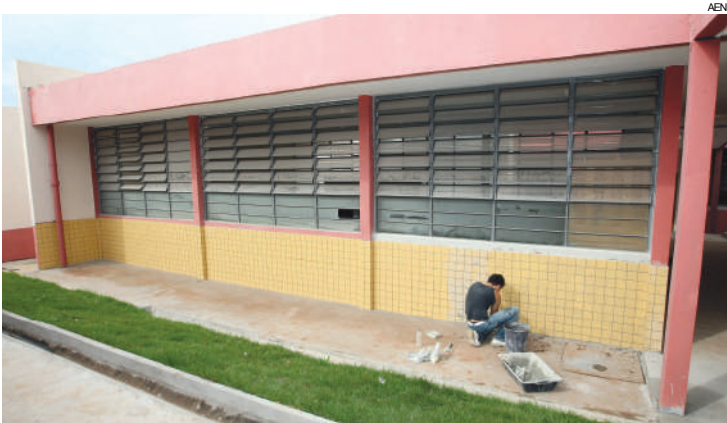
Obras de reformas no Colégio Estadual Olinda Truffa de Carvalho.
