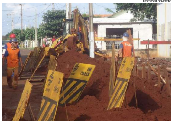
Obras em Santa Terezinha estão em andamento desde abril
