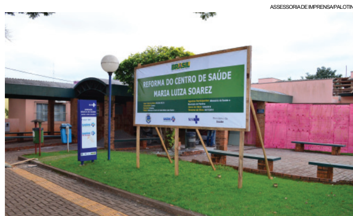
Obras de reforma do Posto Central de Saúde Maria Luiza Soarez
