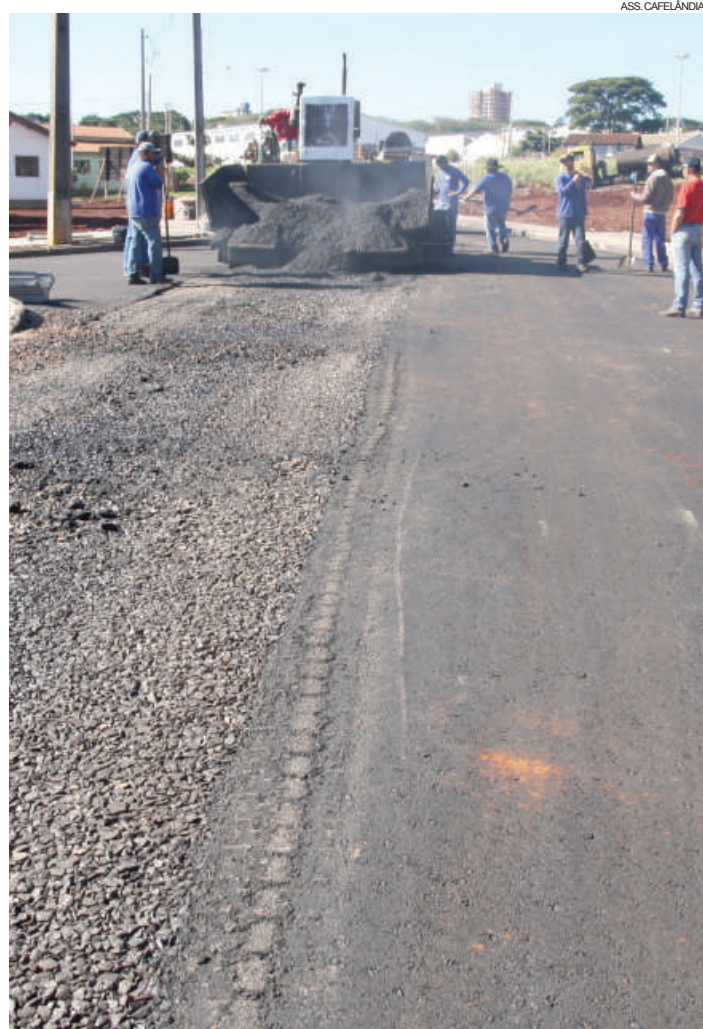
Com as obras de pavimentação concluídas, prefeito já iniciada nova UBS
