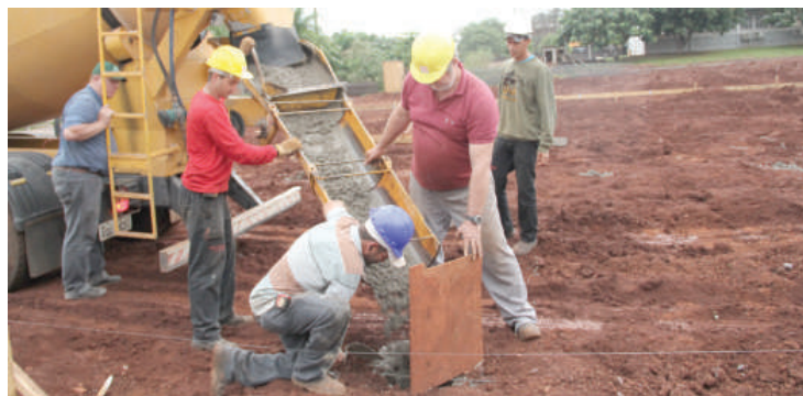
Trabalhos da nova unidade básica de saúde então centralizados na fundação da estrutura
