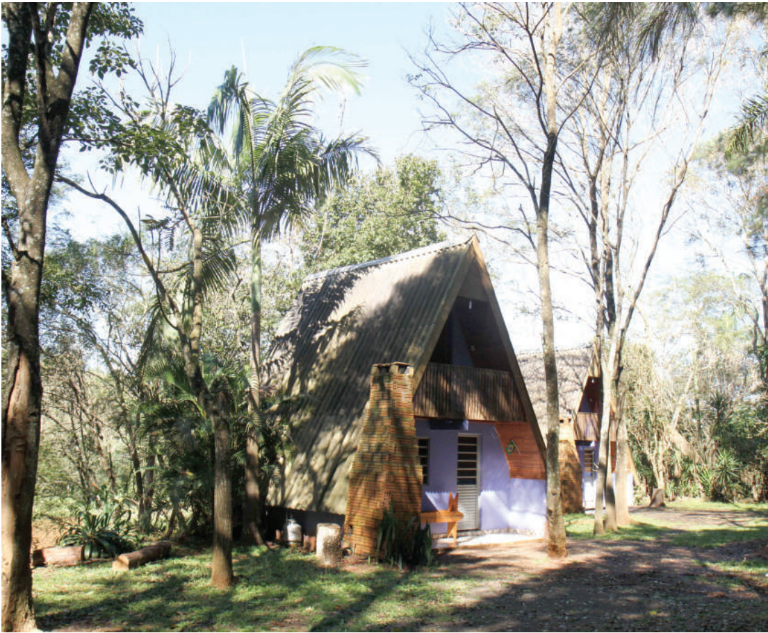
Quatro chalés estão disponíveis para locação no Recanto Familiar
