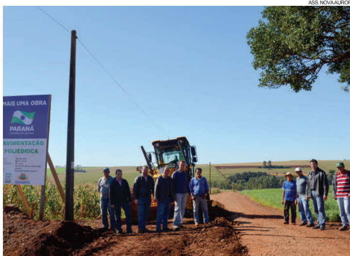
As obras de calçamento poliédrico são uma parceria entre o Estado e o município
