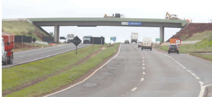
Equipe trabalhou ontem para liberação do viaduto
