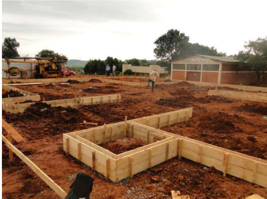
Além da nova UBS, outras grandes obras estão sendo executadas em Boa Vista da Aparecida
