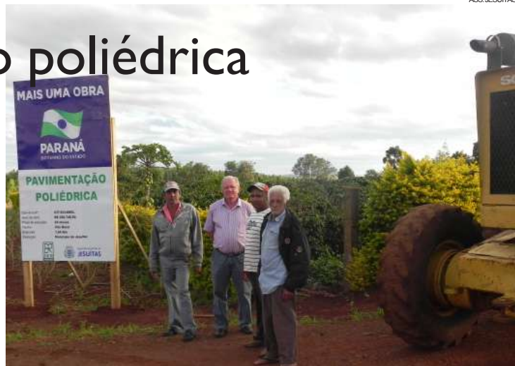
Obra de pavimentação começa na Vila Rural
