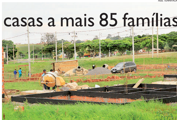
Autorização para a construção das casas ocorreu há mais de um mês. Obras deverão estar prontas em no máximo dois anos
