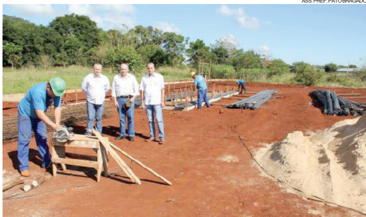
Em visita à obra, representantes municipais e estaduais celebram o início da construção do novo colégio estadual
