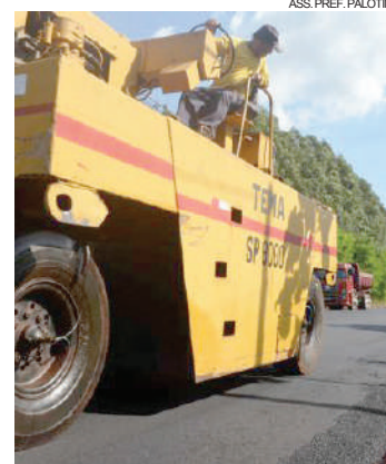
A segunda etapa de obras do PAC começa no bairro BNH
