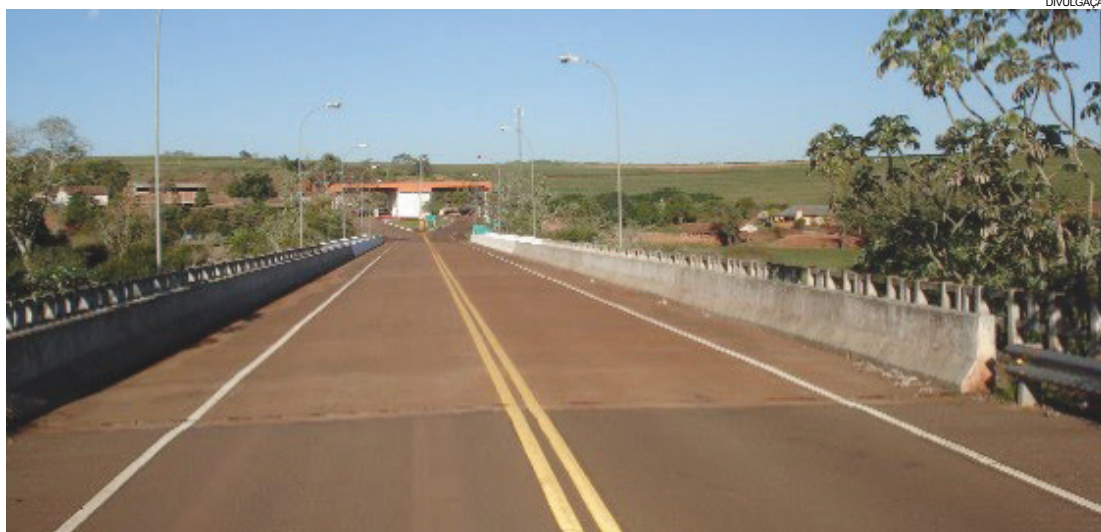
Ponte sobre o rio Santo Antônio foi inaugurada durante o primeiro governo de Roberto Requião, em 1996
