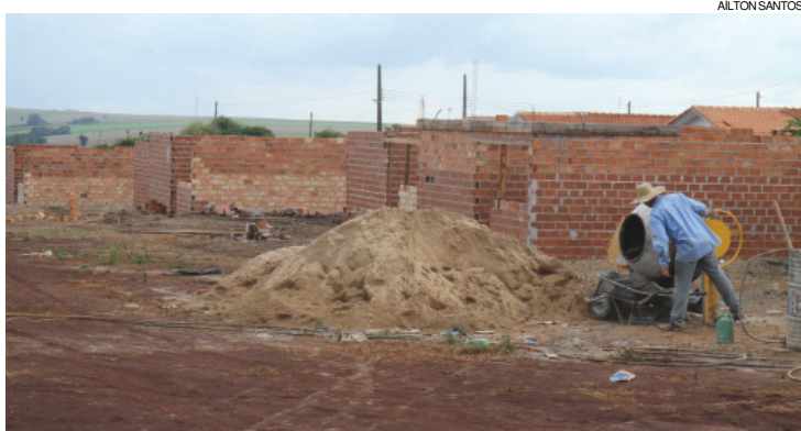
Em Tupãssi, as obras de habitação só foram retomadas após três meses de paralisação. Previsão é de que já estivessem concluídas
