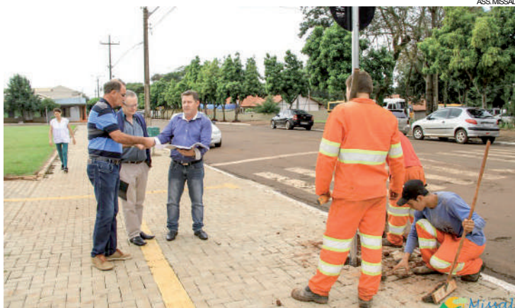
O trabalho de implantação de novas placas já acontece
