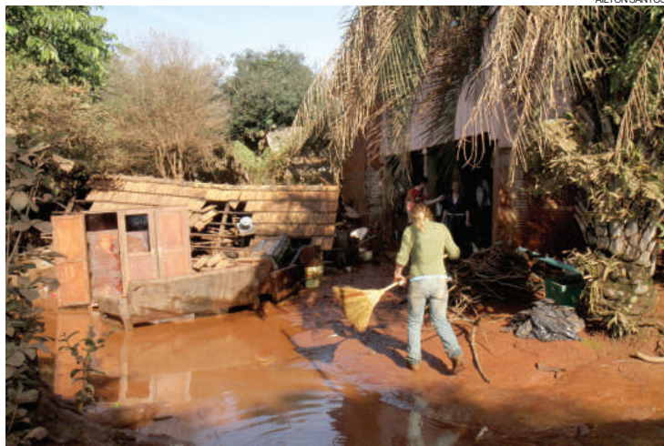
Próximo a ponte do Rio Iguaçu, residências foram totalmente alagadas
