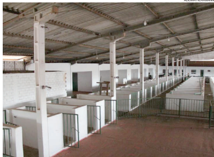
Barracão pré-moldado possui área total de 1.607,78 metros quadrados
