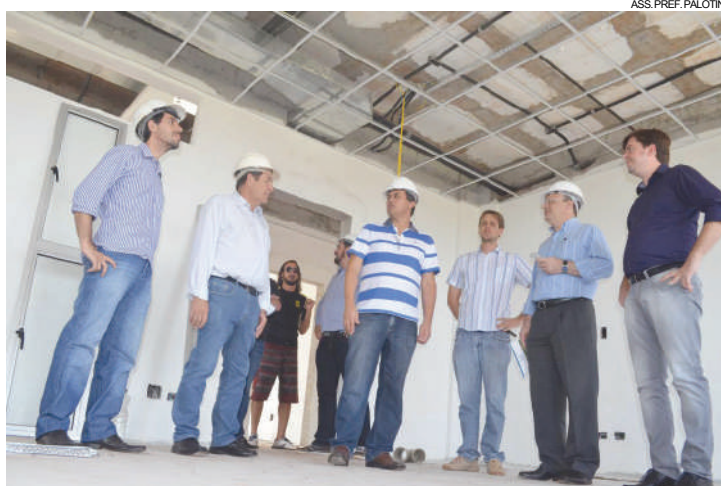
Autoridades inspecionam as obras de mais dois blocos em construção na unidade da UFPR em Palotina
